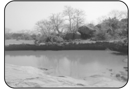
తాటికొండ గుట్ట మీద పాపన్న నిర్మించిన చెక్ డ్యాం
